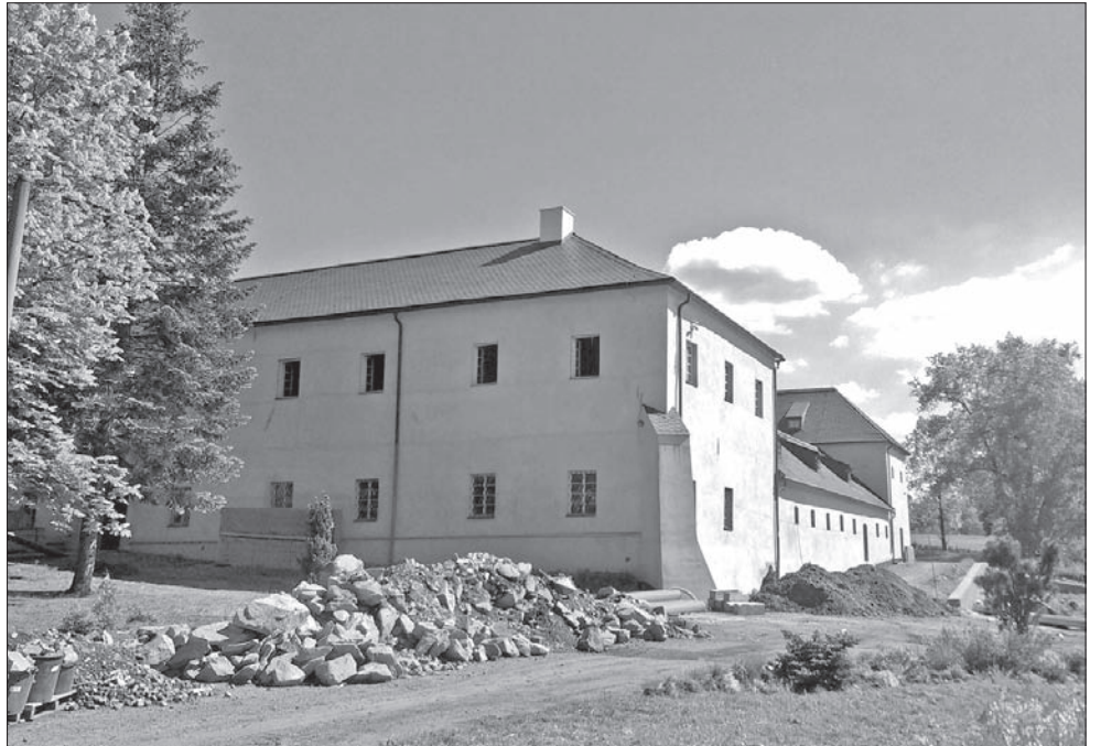
Stary Dwór w Rychwałdzie to duża posiadłość. Jego remont jeszcze jakiś czas potrwa.
