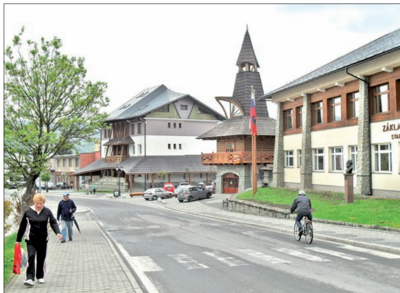
Zbójnicka Baszta (budynek z wieżą) była pierwszą „jaskółką” nowego oblicza gminy.
