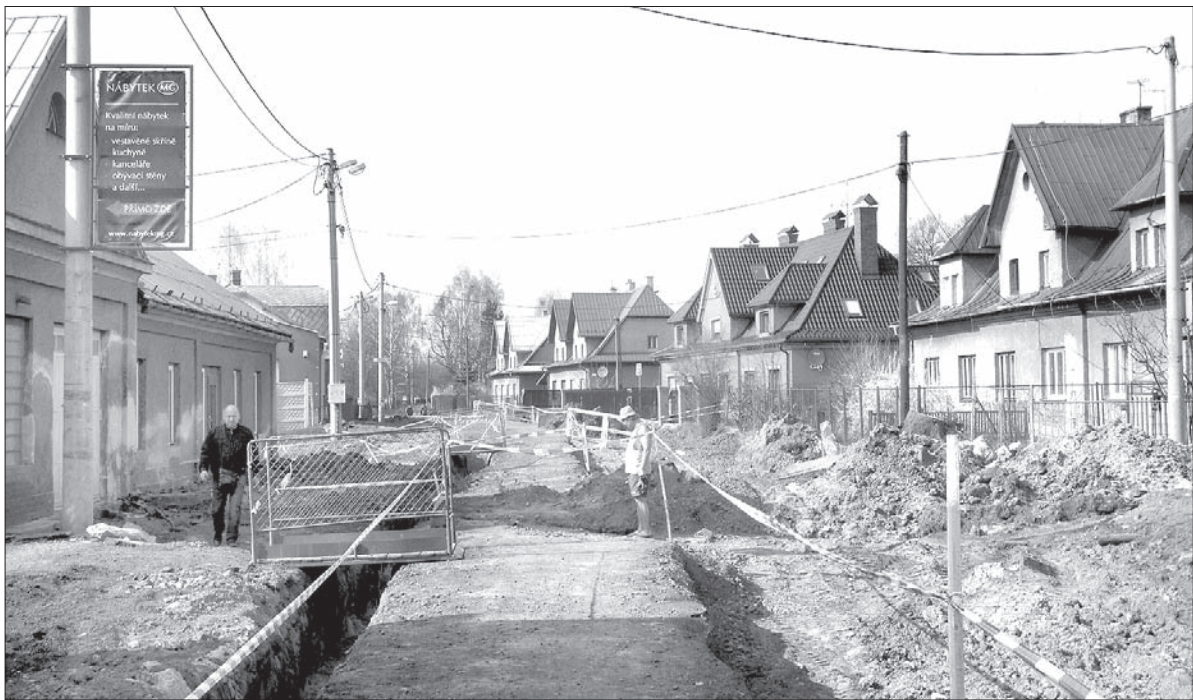
Główna droga dojazdowa do centrum Piotrowic zamieniła się w plac budowy.
