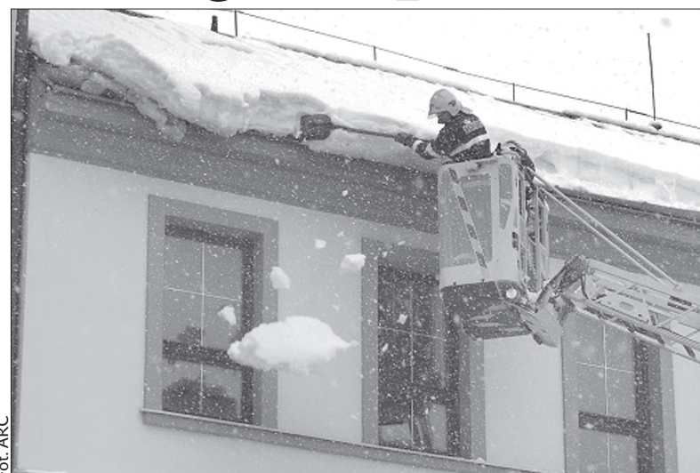
Strażacy pomagają przy usuwaniu śniegu z dachów w przypadku bezpośredniego zagrożenia dla przechodniów.
