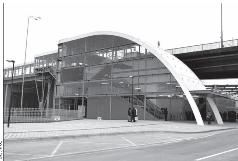
Nowy terminal komunikacji miejskiej w Ostrawie-Swinowice.
