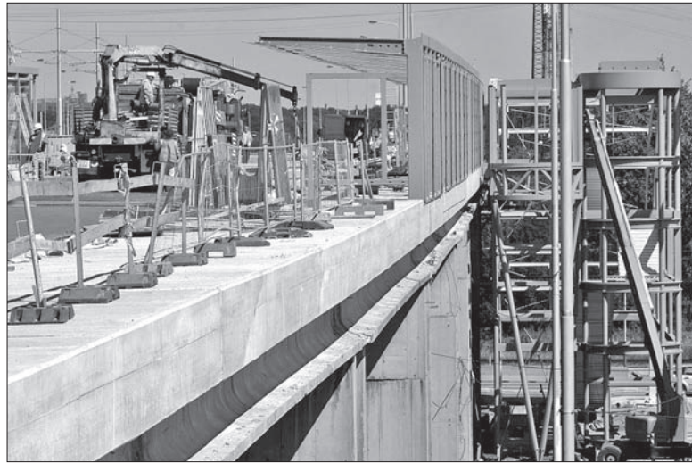
Remont Mostów Swinowskich trwa.
