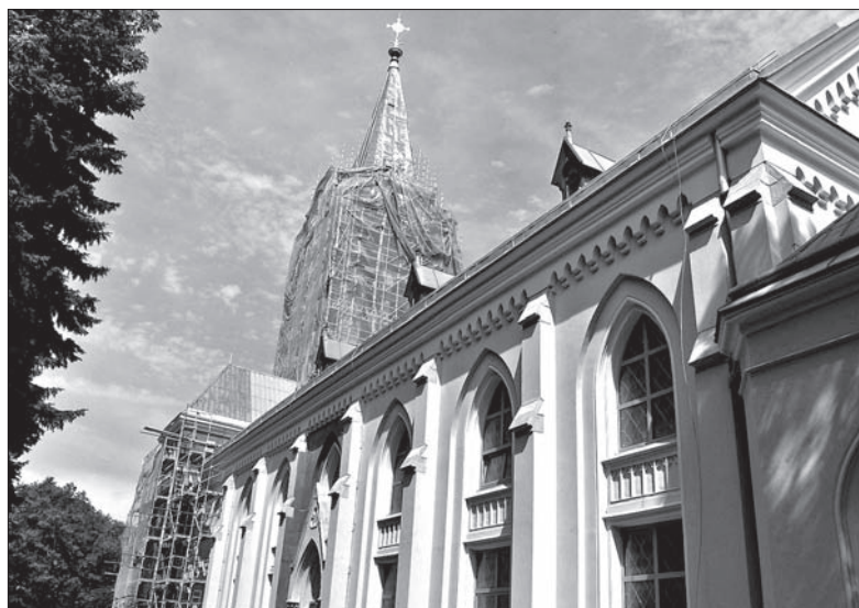
Kościół jest remontowany od ubiegłego roku.
