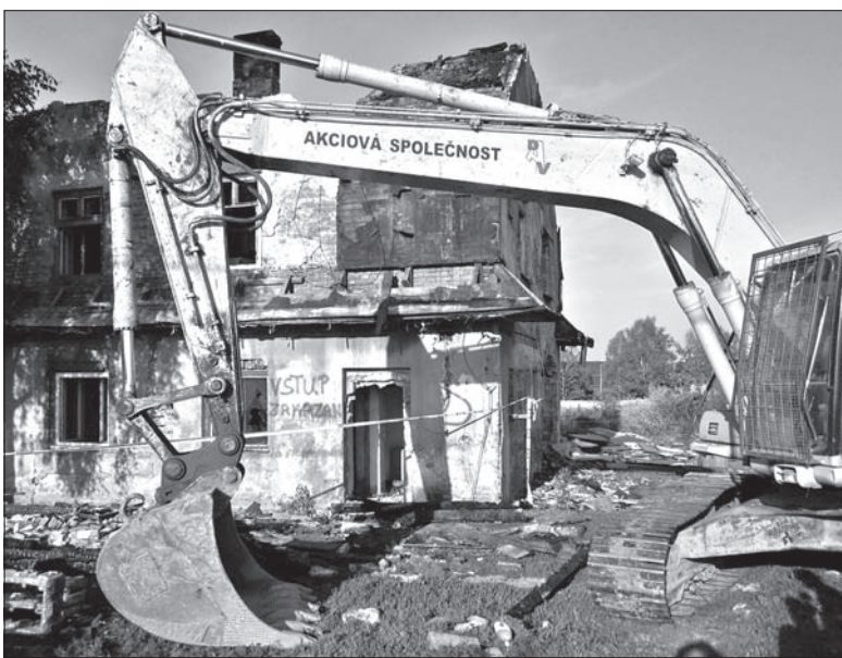
Ostatni dom w kolonii Wagonka tuż przed wyburzeniem.
