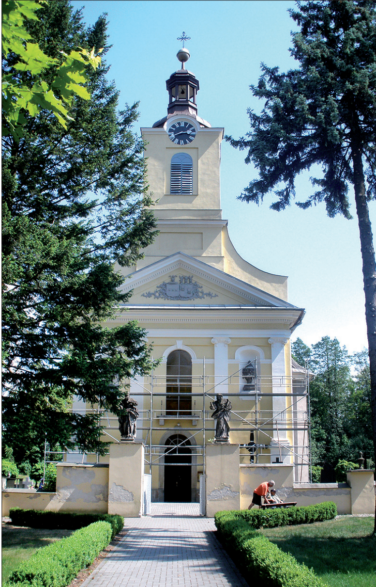
W Ropicy są dwa budynki wpisane na listę zabytków. Jednym z nich jest kościół katolicki, który właśnie przechodzi remont.
