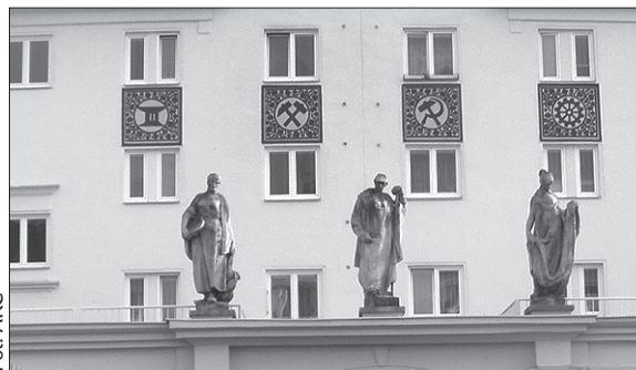
Na elewacjach domów odnowiono również charakterystyczne elementy zdobnicze. (dc)
