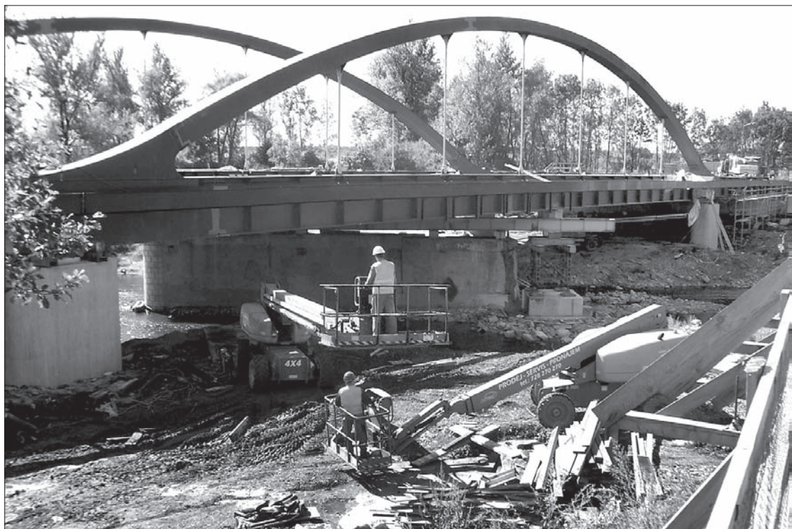
Prace przy budowie karwińskiego mostu wydłużą się o pięć dni.
