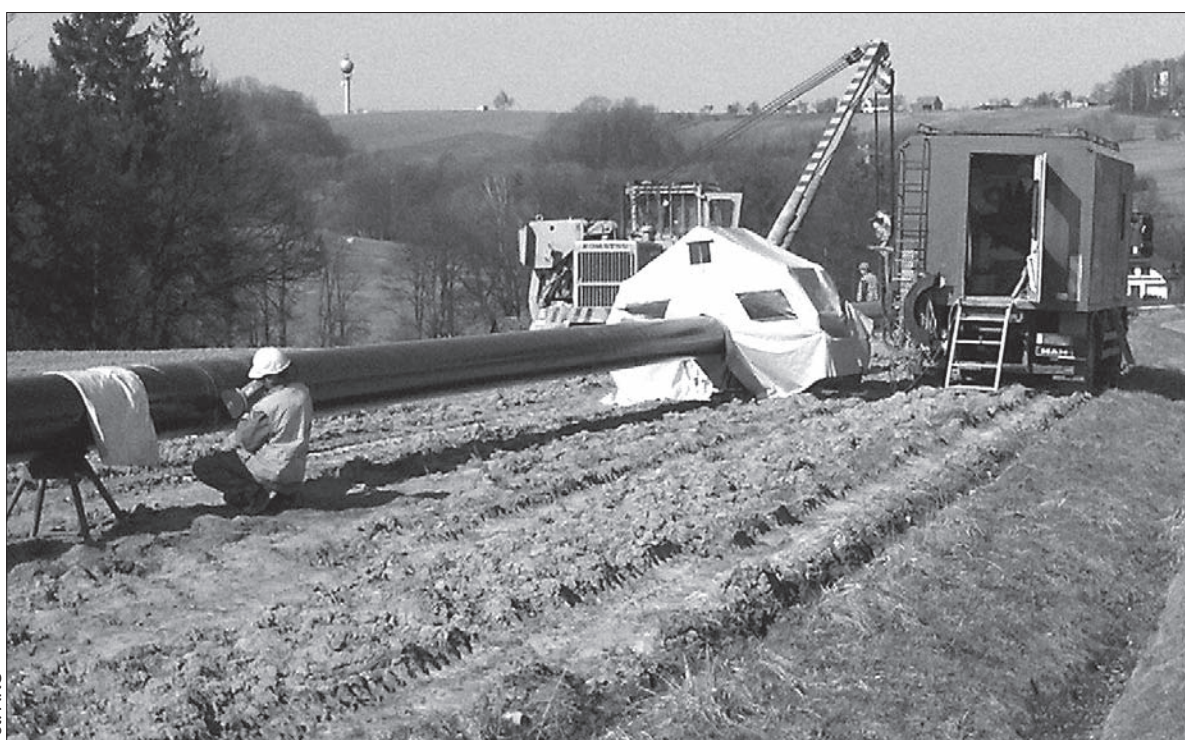
Zdjęcie z budowy polsko-czeskiego gazociągu.
