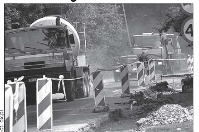
Trwa przebudowa drogi powiatowej nr 2619s.
