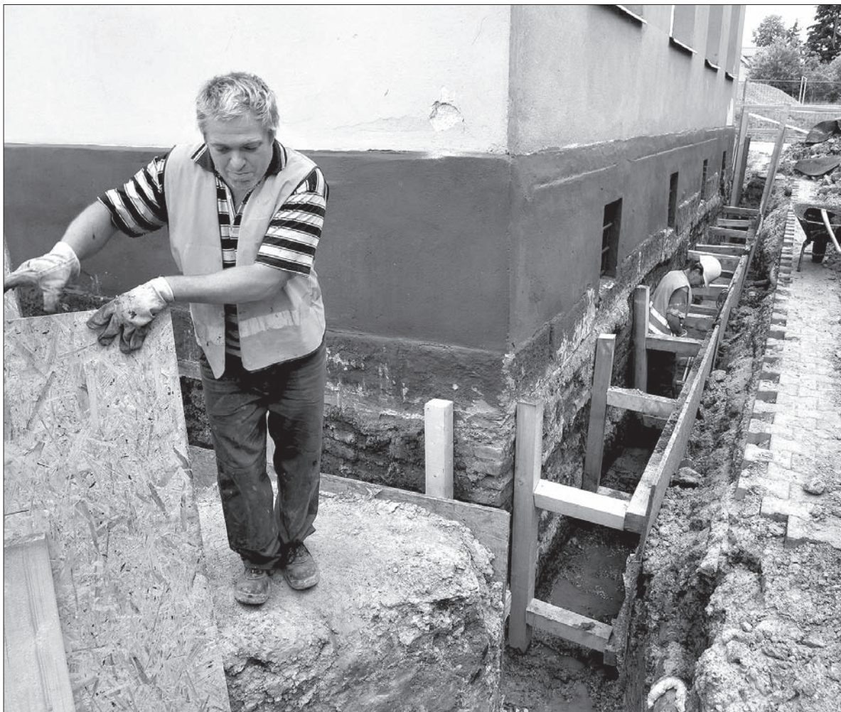
Rozpoczął się remont polskiej szkoły w Hawierzowie-Błędowicach.
