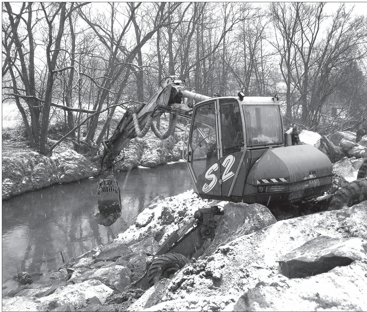
Trwa przygotowanie dna i brzegu Piotrówki do budowy ściany przeciwpowodziowej.
