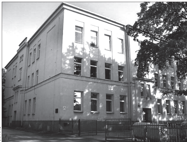
Frysztacka PSP znajduje się w bardzo starym budynku.
