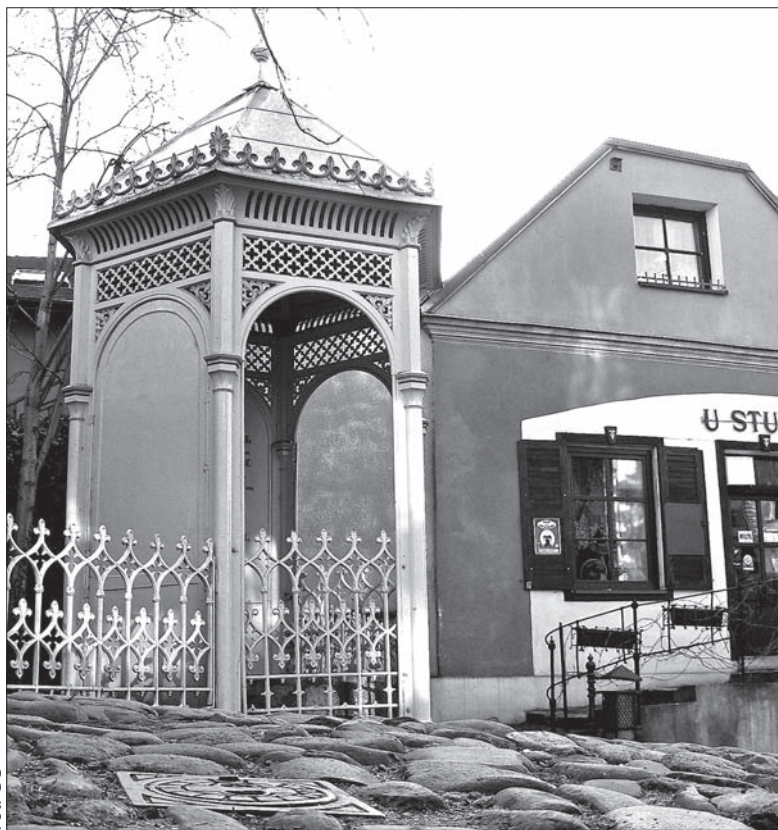
Studnia Trzech Braci nie była kompleksowo remontowana od dziesięcioleci.
