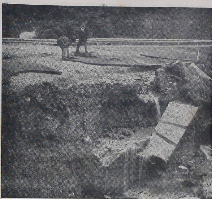
Co się stało ze wspaniałą drogą do Paranaguá po podmyciu ziemi przez deszcz i zawaleniu się skalnej ściany wazącej 30 ton.
