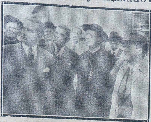
Inz. Edmund Gardoliński pokazuje s.p. J. E. Arcybiłskupowi i Gosciom prace budowlane w Porto Alegre
