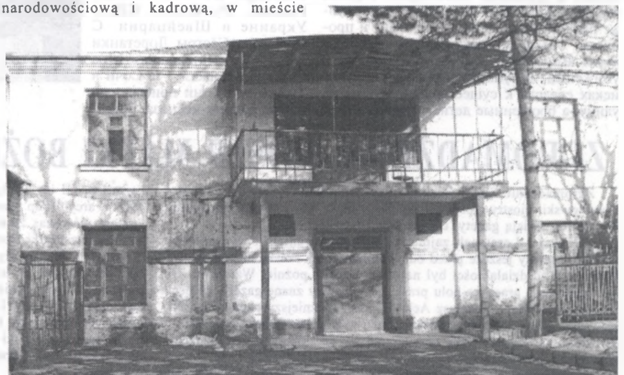
Gmach byłego kościoła (stan obecny)
