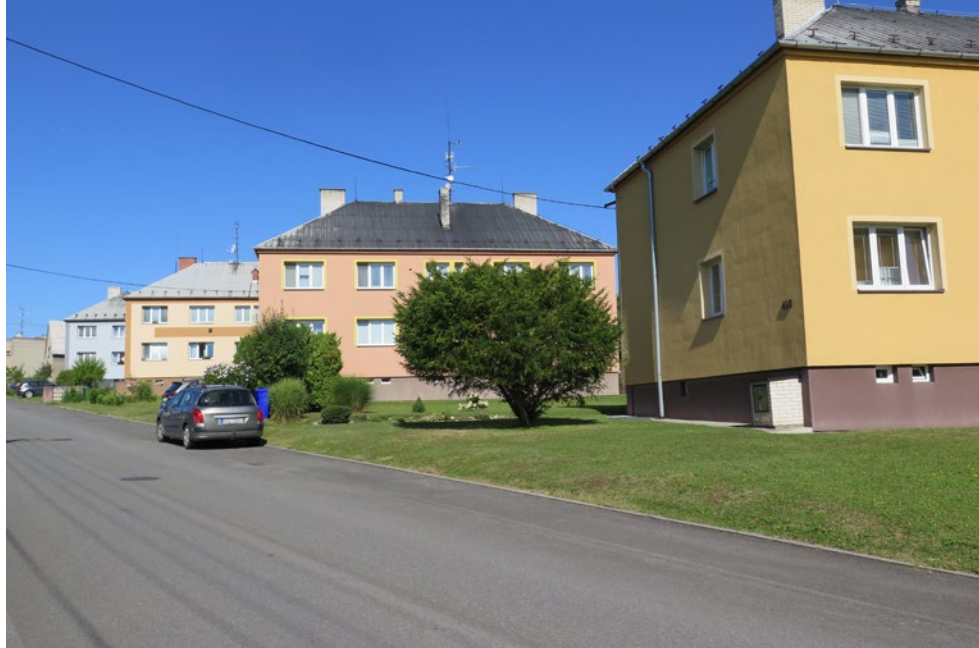
[ 2 ] Zabudowa z lat 50. XX wieku przy ul. Długiej
