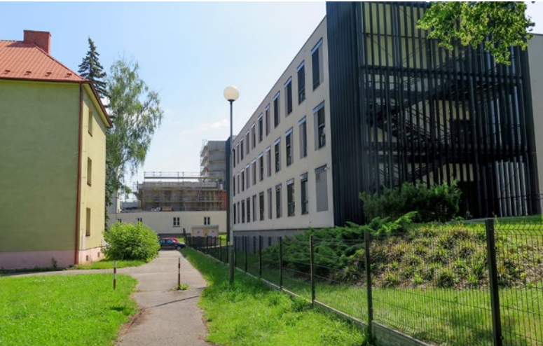
[ 13 ] Przylegająca do budynku Szpitala Górniczego dawna zawodowa szkoła górnicza. Obecnie budynki są połączone i oba zajmuje szpital.
