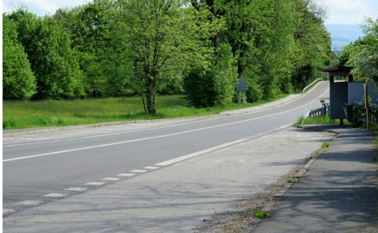
[ 31 ] Przystanek autobusowy Czeski Cieszyn, Mistrzowice, skrzyżowanie (Český Těšín, Místřovice, rozc.)
