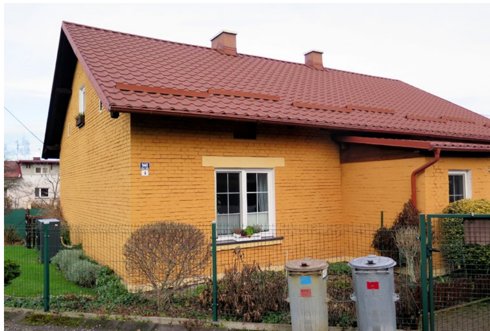
[ 15 ] Zachowany w pierwotnej formie, choć częściowo zmodernizowany budynek dawnej kolonii robotniczej
