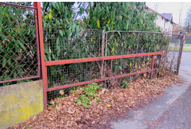
[ 18 ] Poręcz – pozostałość po mostku na Młynówce, która w dalszym biegu została zasypana
