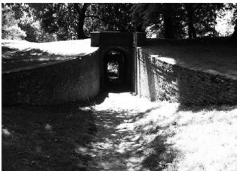
Schody angielskie. Przejście między ogrodem dolnym i górnym
