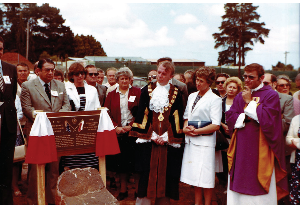
Uroczystość poświęcenia kamienia węgielnego pod budowę Domu Polskiego „Syrena”
