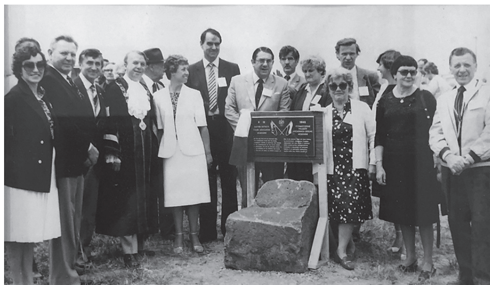
Uroczystość poświęcenia kamienia węgielnego pod budowę Domu Polskiego „Syrena” 5.12.1982
