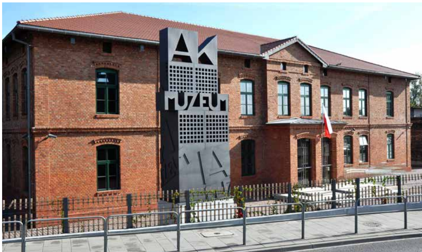
Budynek muzeum robi wrażenie. Prace budowlane zakończyły się w 2011 r. Sama historia placówki jest znacznie starsza Fot. Mirosław Żak/Muzeum AK
