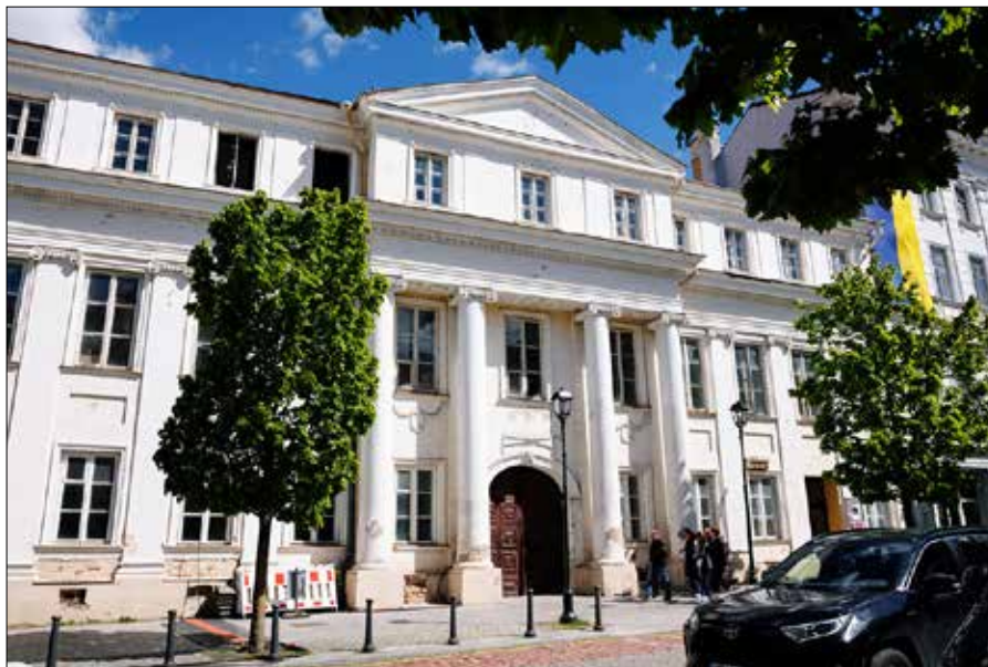
Przy ulicy Wielkiej 36 znajduje się klasycystyczna budowla znana jako pałac M. Abramowiczowej Fot. Marian Paluszkiwicz
