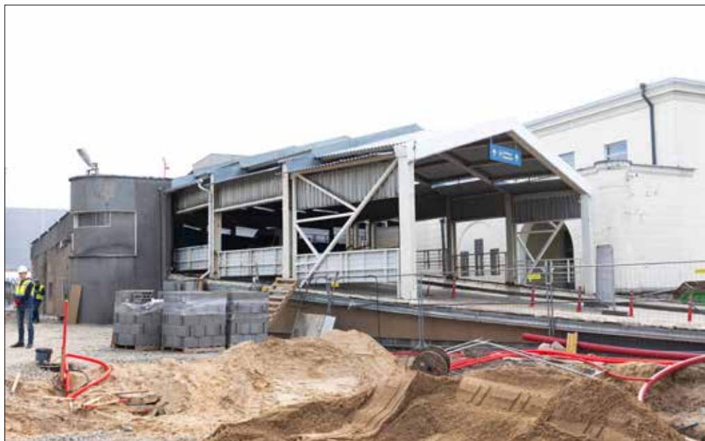
■ Na wileńskim lotnisku trwają prace rekonstrukcyjne terminali Fot. Dainius Labutis, ELTA
