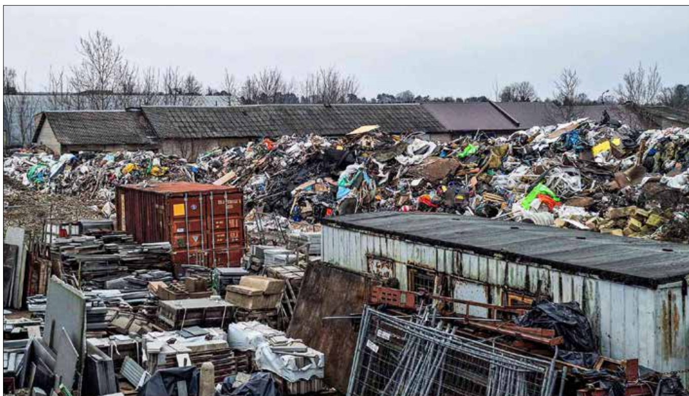
Domy mieszkalne znajdują się kilkadziesiąt metrów od wysypiska Fot. „Vardan Salininkų”
