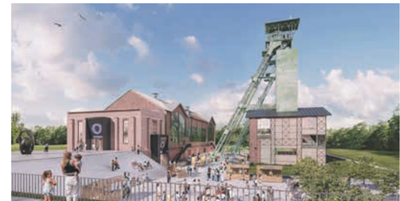
• Wizualizacja centrum informacji turystycznej i wyremontowanego budynku maszynowni kopalni Gabriela. Fot. materiały prasowe POHO Parku
