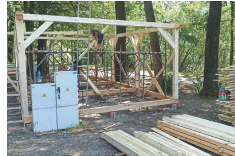
• Nowa scena plenerowa w budowie. Fot. Miasto Jabłonków
