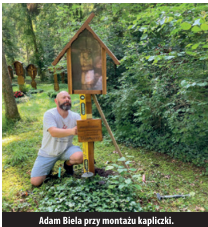
Adam Biela przy montażu kapliczki.
