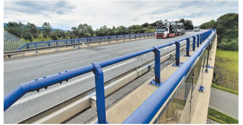
• Most drogowy w Nawsiu od poniedziałku będzie remontowany. Fot. DDA
