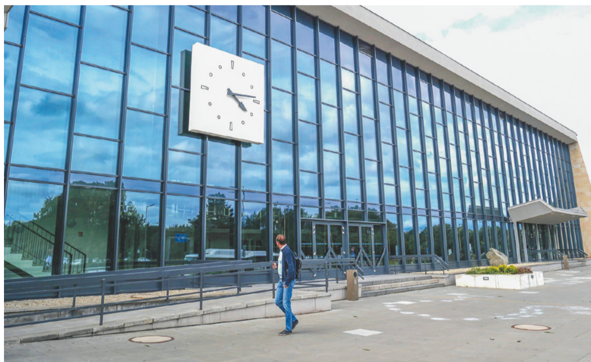
• Budynek dworca w Hawierzowie jest już wyremontowany. Teraz rozpocznie się modernizacja torów, peronów, przejścia podziemnego. Fot. DANUTA CHLUP
