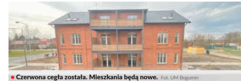
• Czerwona cegła została. Mieszkania będą nowe. Fot. UM Bogumín
