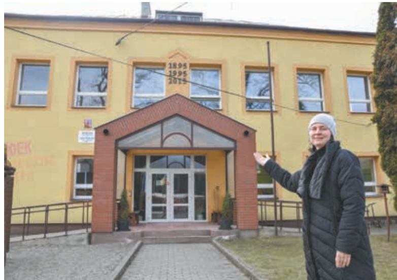
• Dyrektorka Katarzyna Śafak przed szkołą, która dzięki remontowi dachu znacząco zmieni swój wygląd.
