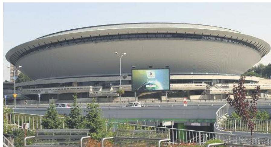
Strefa Kultury w Katowicach usytuowana w sąsiedztwie legendarnego Spodka jest jedną z najbardziej rozpoznawalnych przestrzeni w mieście
