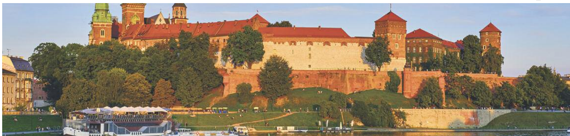
Kraków – widok z poziomu Wisły na Wawel
