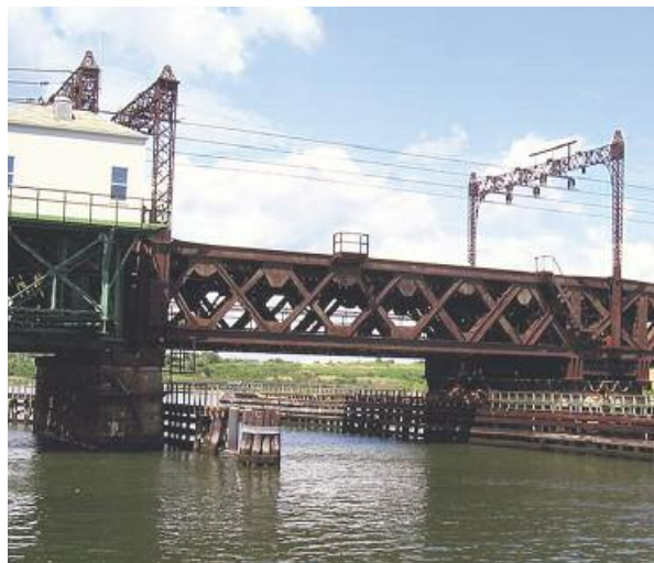
Dofinansowanie zostanie przeznaczone m.in. na modernizację mostu kolejowego w Norwalk
