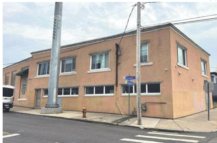
Jeden z czterech wystawionych na sprzedaż budynków, które należą do KZ Carpentry
