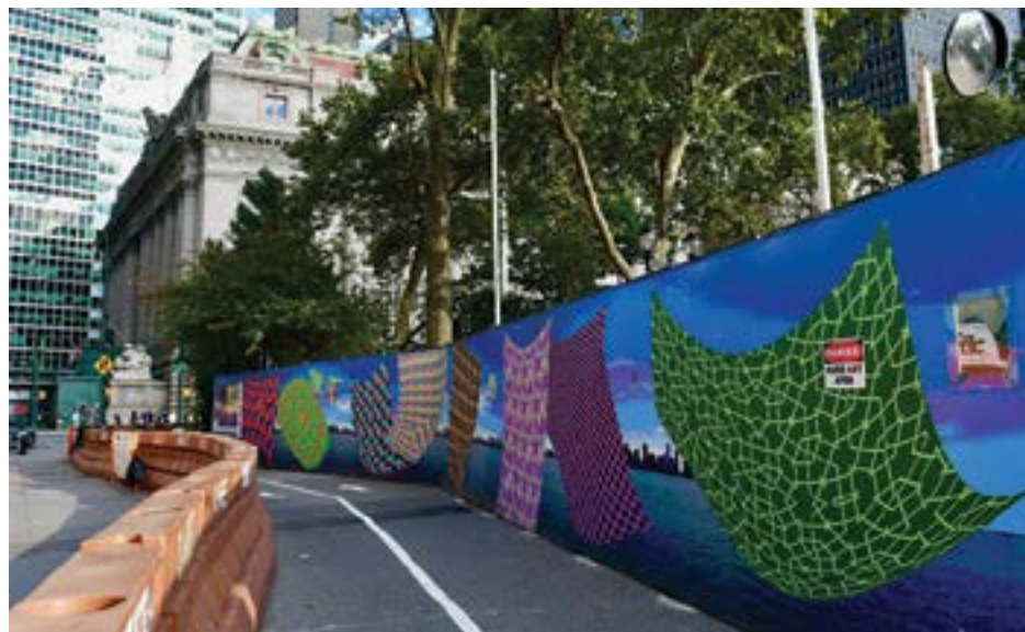
Battery Park na czas remontu został odgrodzony, ale wytyczono ścieżki rowerowe
