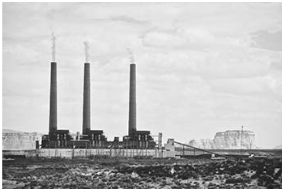
Nieistniejąca już elektrownia pobudowana w latach 70. ubiegłego wieku na terenach rezerwatu Navajo Nation. Zdjęcie z 2007. W tej okolicy niebo było rzadko czyste.
