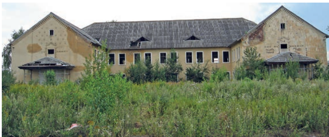
W TYCH KOSZARACH MIESZKAŁ WYSOCKI-JUNIOR. PRZYGOTOWANE DO ROZBIÓRKI
