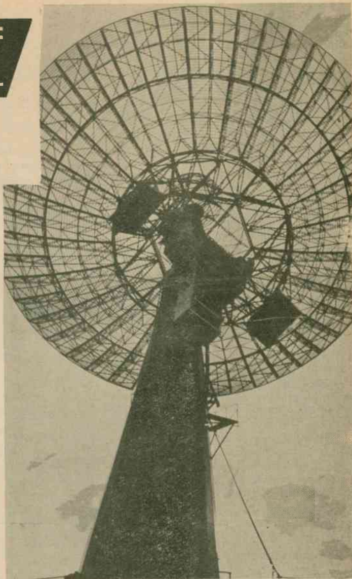
Księżyc stacją łącznikową dla telekomunikacji. Oto antena w formie ogromnego talerza służąca do tych celów — wynalazek amerykański, który wymagał 10 lat poszukiwań naukowych
