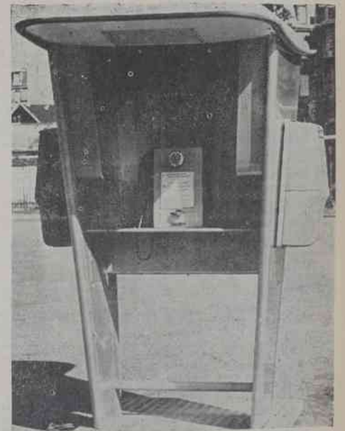
«NIEMA» POCZTA. W miejscowościach letniskowych różnych krajów Europy instaluje się przed sezonem „niemie” poczty bez urzędników pocztowych, dostępne bez przerwy dnem i nocą. Urządzenie to zawiera automat do sprzedaży znaczków i przekazów pocztowych, do zmieniaania pieniędzy na drobne, telefon i skrzynkę pocztową.
