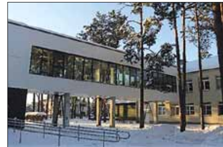
W Gimnazjum im. K. Parczewskiego w Niemenczynie zakończyliśmy II etap prac budowlanych
