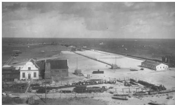
Budowa portu morskiego w Gdyni. 1925 rok. Źródło: NAC
