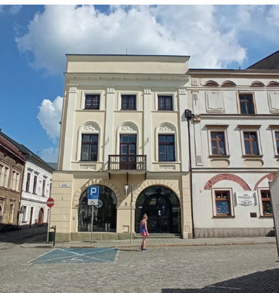
Fasada domu nr 14 wschodniej pierzei rynku w 2020 roku
