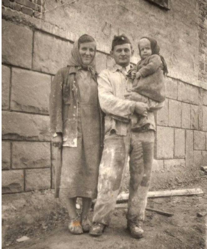
Anna i Władysław Drongowie w ubraniach roboczych. Większość prac przy budowie domu wykonali sami. Na rękach męża autorki wspomnień syn Władysław.
