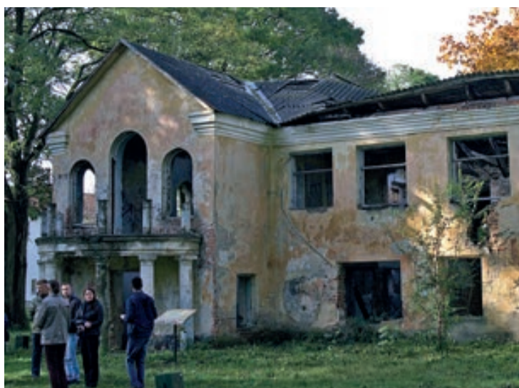
ZNISZCZONE SKRZYDŁO PAŁACU
