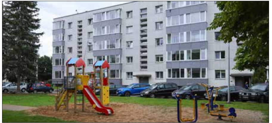
Renowacja bloków wielomieszkańczych na Litwie. Fot. z archiwum APVA
