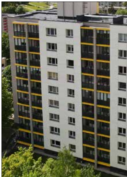
Renowacja bloków wielomieszkańczych na Litwie. Fot. z archiwum APVA
